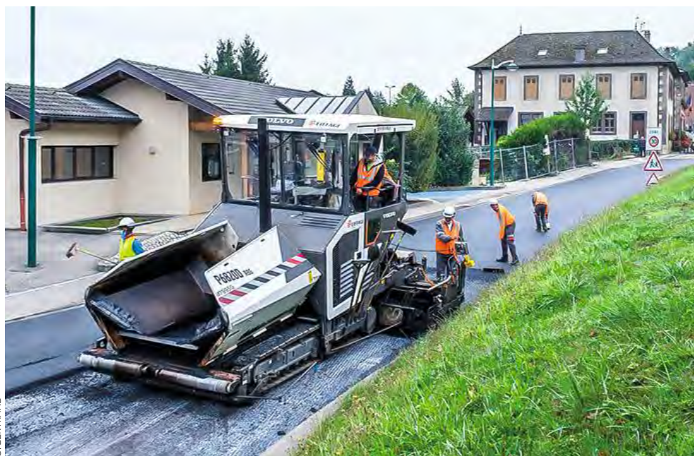
Installation d'un revêtement biophalt, fabriqué à partir de la poix.
