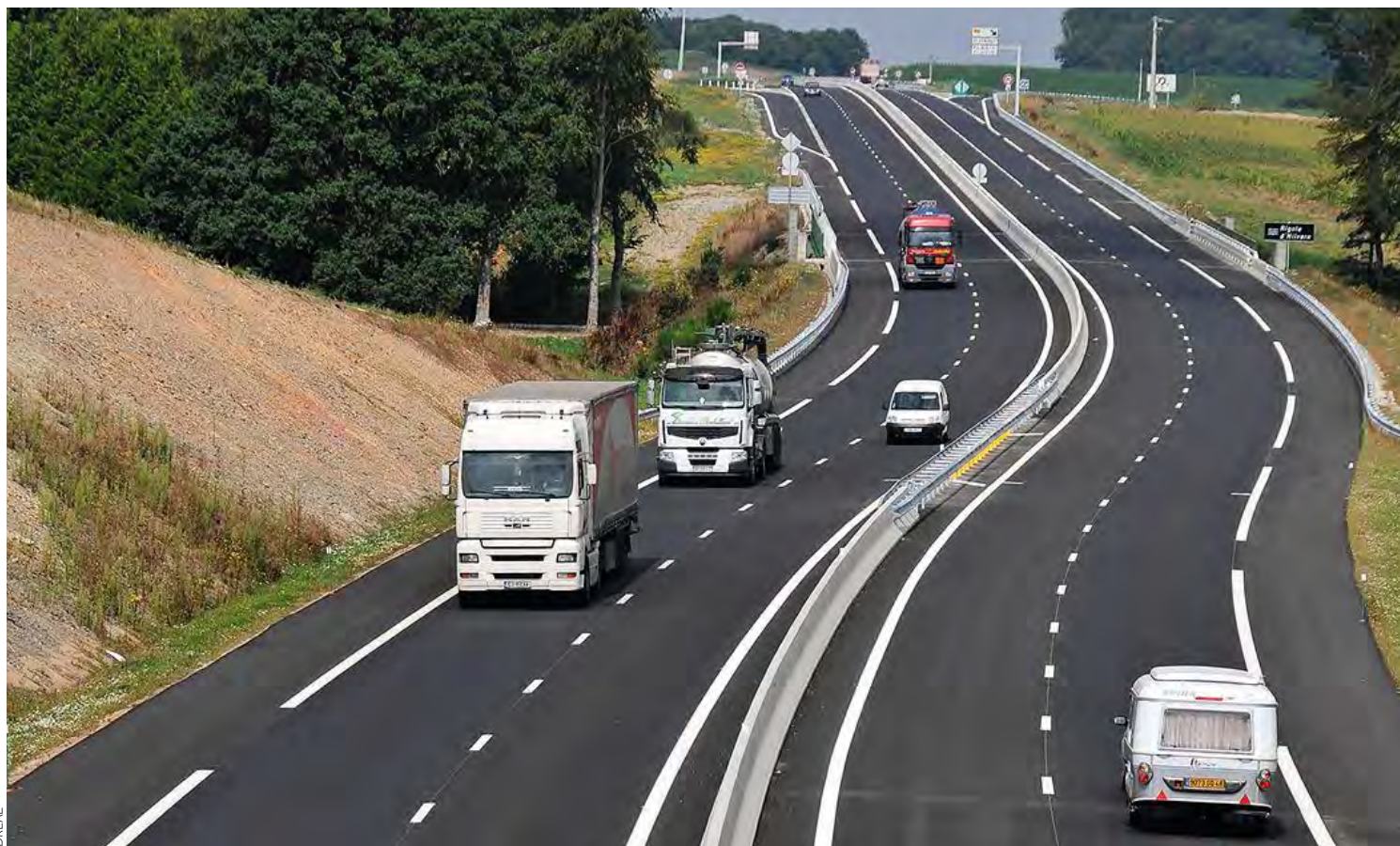
La RN 164, reliant l'Ille-et-Vilaine au Finistère, devrait être achevée en... 2030.
