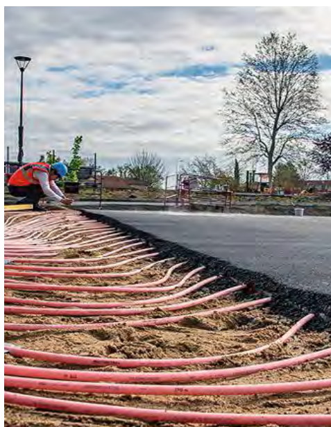
Pose de câblage sous une chaussée, visant à récupérer la chaleur du soleil.
