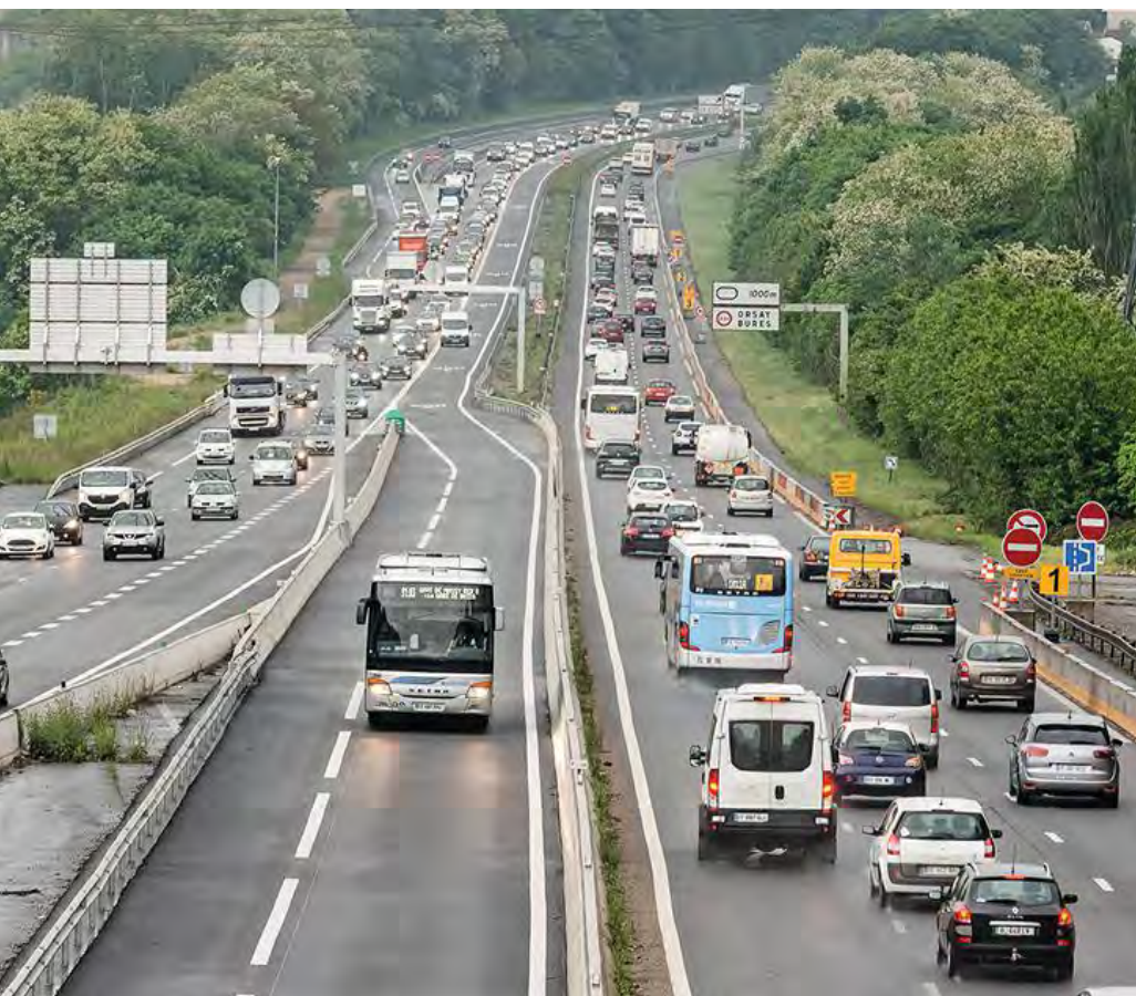
Pour des trajets plus rapides, des voies sont dédiées aux bus sur certaines autoroutes.
