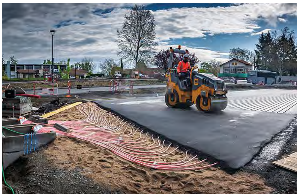
Installation d'un réseau de tubes sous le bitume (Power Road d'Eurovia).
