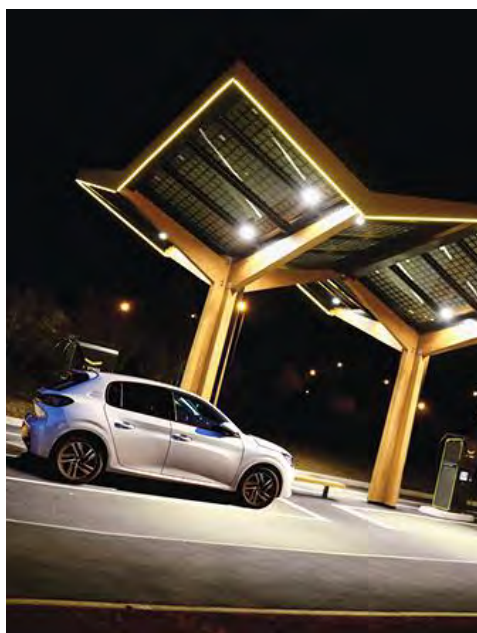
Une station de recharge sur l'A31, près de Gevrey-Chambertin (Côte-d'Or).
