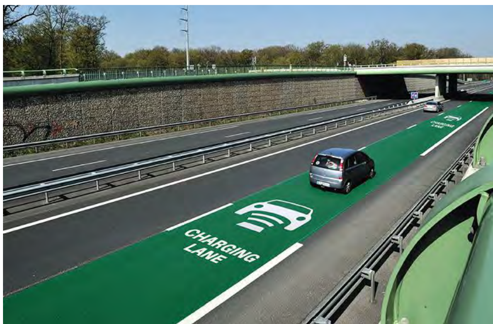
Une route à recharge électrique par induction, actuellement en test en Allemagne.
