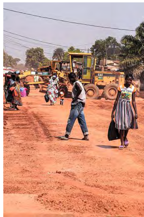
L'UE aide à financer des travaux d'aménagement routier à Bangui.
